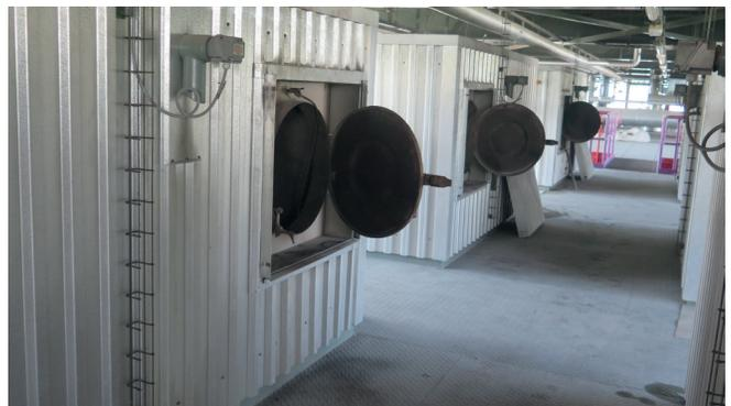
Portes d'accès de l'électrofiltre
