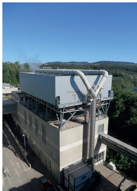
bâtiment de production de l'énergie
