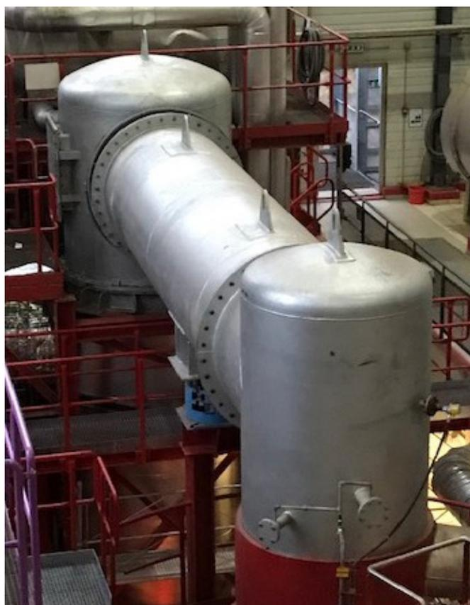
Der Rauchgasabzug besteht aus den drei Elementen: Brennkammerkopf, horizontalem Verbindungsrohr und Eintrittskammer der Luftvorwärmer. Diese wurden vor Ort einzeln montiert. Jedes dieser Elemente besteht aus einem äusseren Stahlmantel, einer Wärmedämmung und einer inneren Auskleidung aus feuerfestem Beton.
