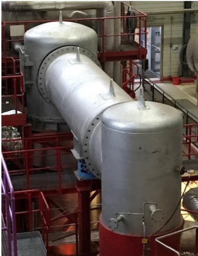
Le carneau est le conduit de fumée horizontal placé entre la sortie du four et les échangeurs de chaleur. Il est constitué de trois éléments qui ont été assemblés sur le site. Chacun de ces éléments comprend une enveloppe extérieure en acier, une isolation thermique et un garnissage interne en béton réfractaire.
