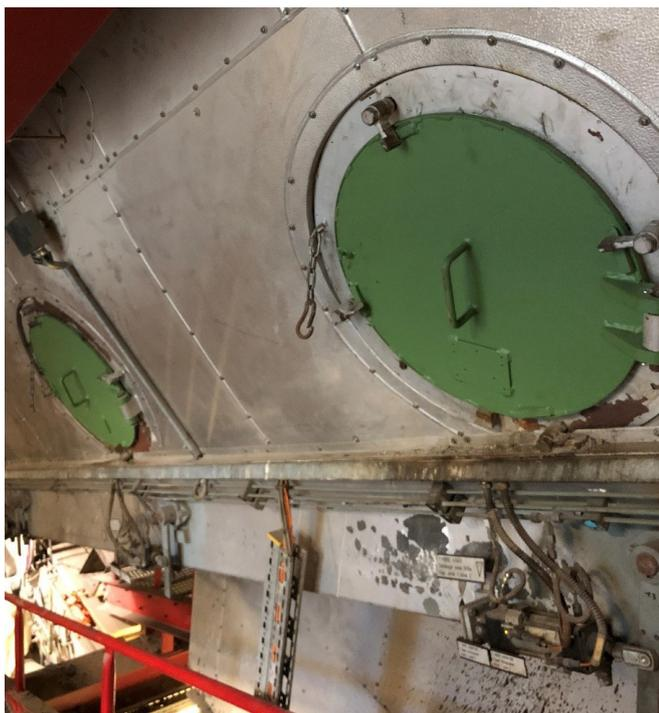
Zugangsklappen unter den Rost
