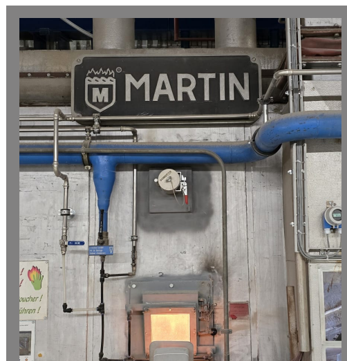
REPLACEMENT DU RÉGULATEUR DE COMBUSTION
